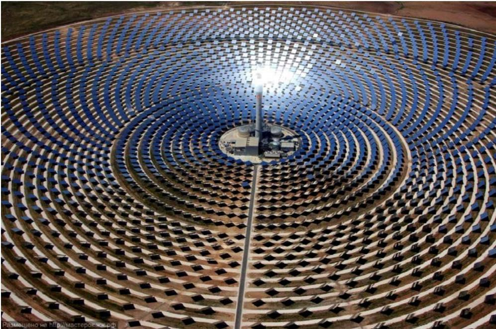
[그림 27] 다량의 헬리오스탯을 사용하여 1500 °C 이상으로 온도를 올릴 수 있는 태양열 화학반응 장치. The Crescent Dunes Solar Energy Project in Tonopah Nevada
